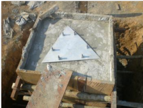
Cimentación de las bases
