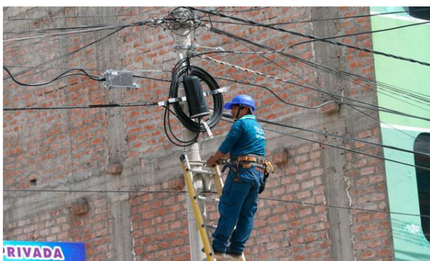
Figura 1. Tendido de fibra óptica.
